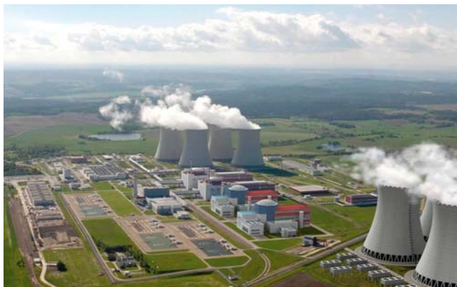
JE Temelín v roce 2020 - budou dva nové bloky realitou?
