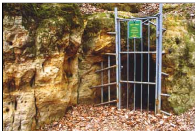
Vstup do jímací štol v oboře Hvězda
