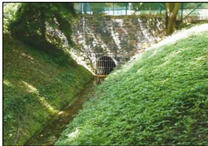
Vtok Brusnice do Jeleního příkopu
