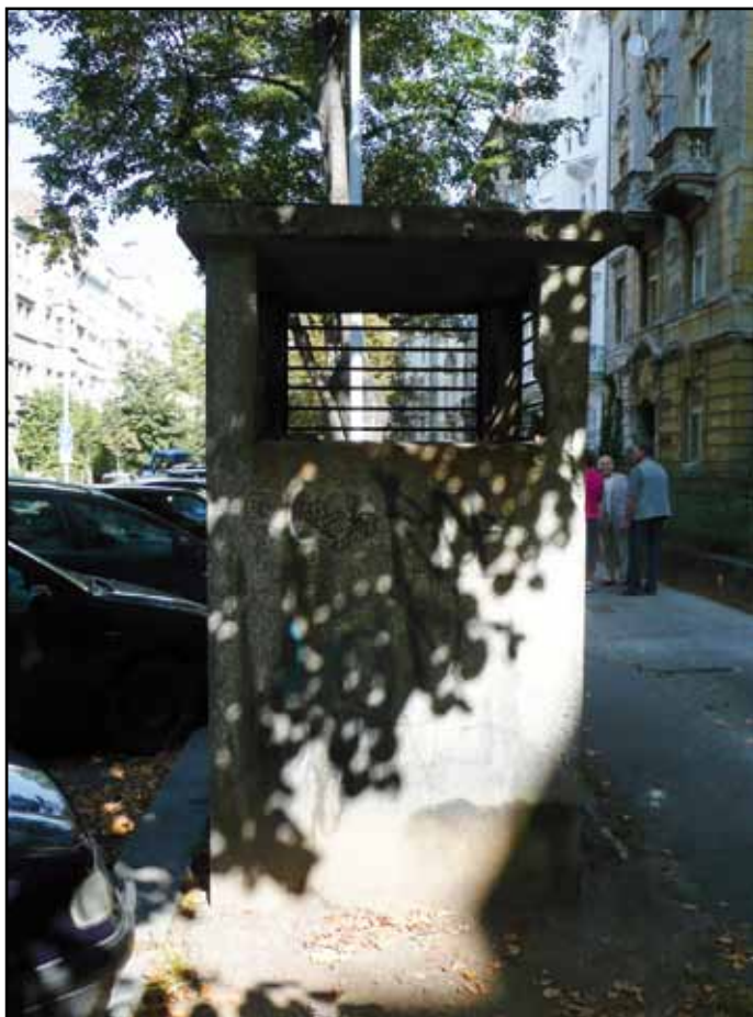
Větrací šachta Rudolfovy štolu v Čechovské ulici
