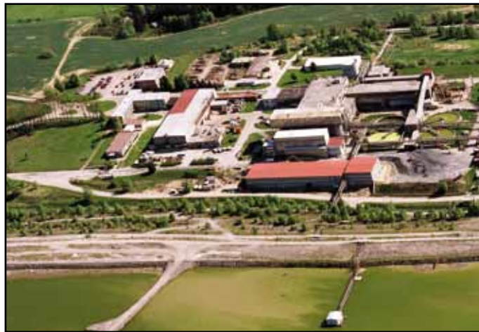
Pohled na chemickou úpravnu – v popředí odkaliště, napravo pět zahušťovacích nádrží, před nimi vytěžená ruda (DIAMO)
