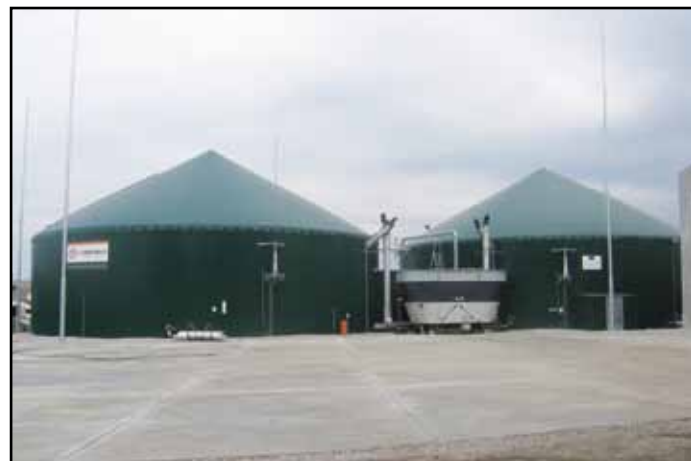
Zemědělská bioplynová stanice Dřevce
