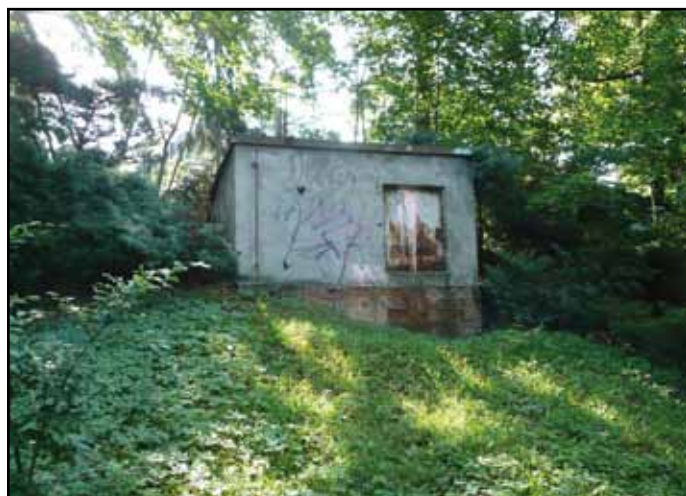
Vodárna nádrže u Rudolfovy štol
