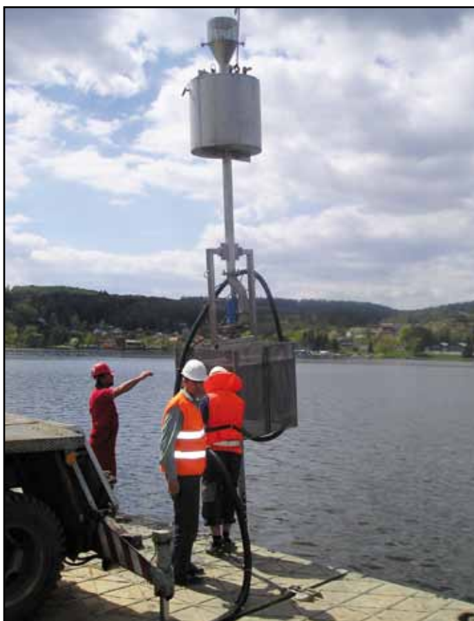
Instalace aeračních věží pod hladinu jezera
