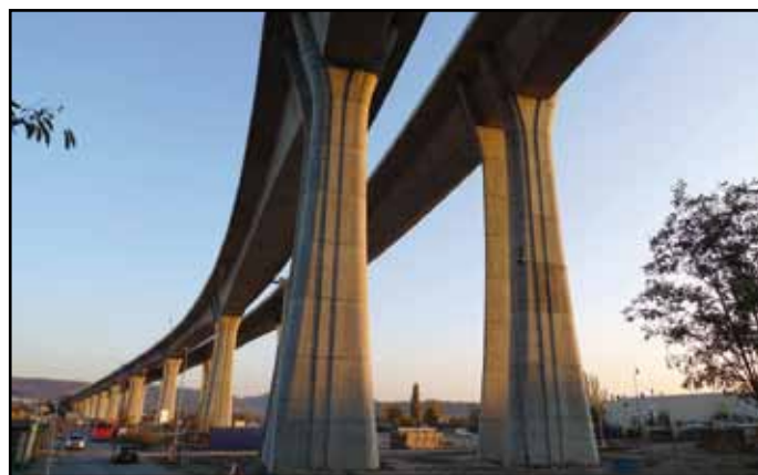
Obr. 8. Estakáda přemostující údolí Berounky.
