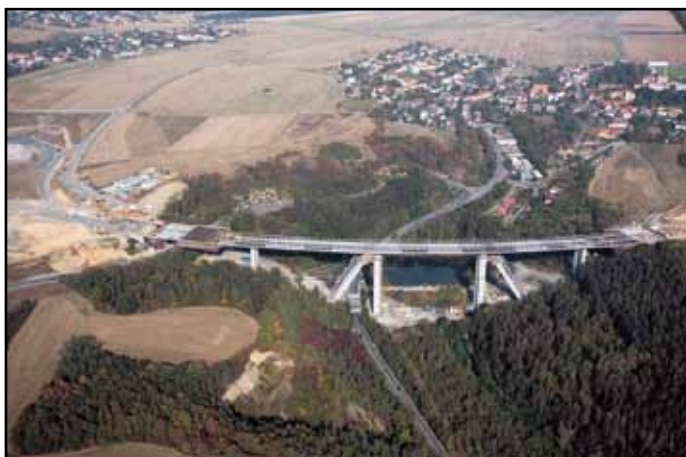
Obr. 11. Výstavba mostu přes Lochkovské údolí
