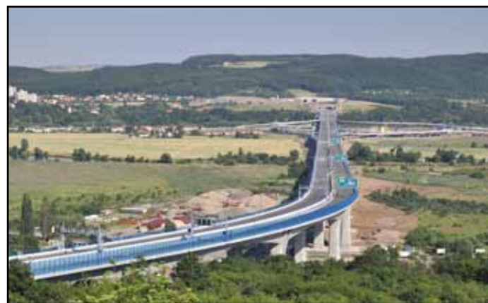
Obr. 9. Celkový pohled na přemostění údolí Berounky a Vltavy
