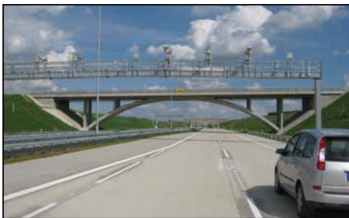
Obr. 3. Obloukový nadjezd silnice Cholupice-Točná
