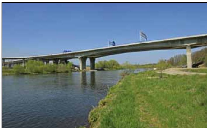
Obr. 5. Most přes Vltavu
