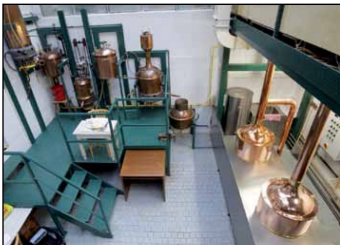
1. prostor pivovaru s oběma varnami v době po instalaci nové varny
