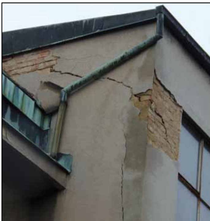
Porušení prvorepublikové vily v důsledku úniku vody do podzákladí
