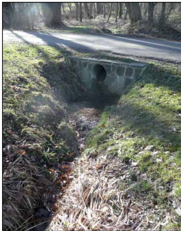
Trocha vody přitéká z bezejmenného potoka
