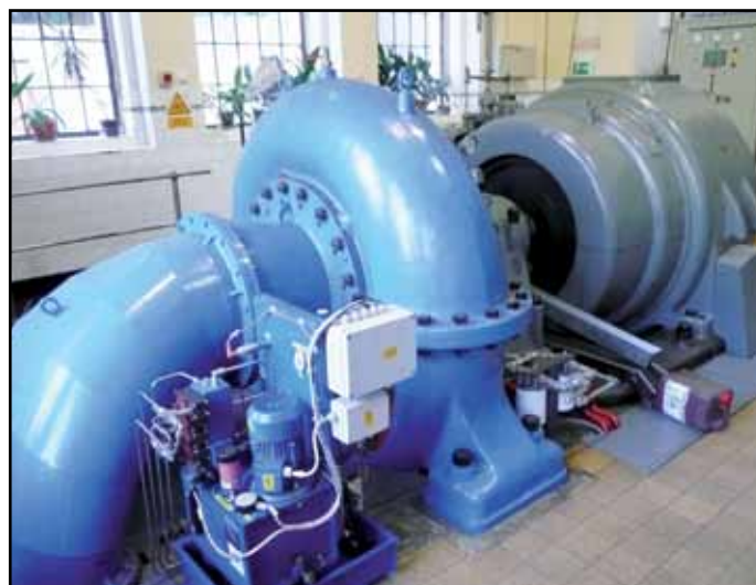
Fotografie z exkurze: Pohled do strojovny MVE Soběnov ... soustrojí turbíny a generátoru v MVE Soběnov
