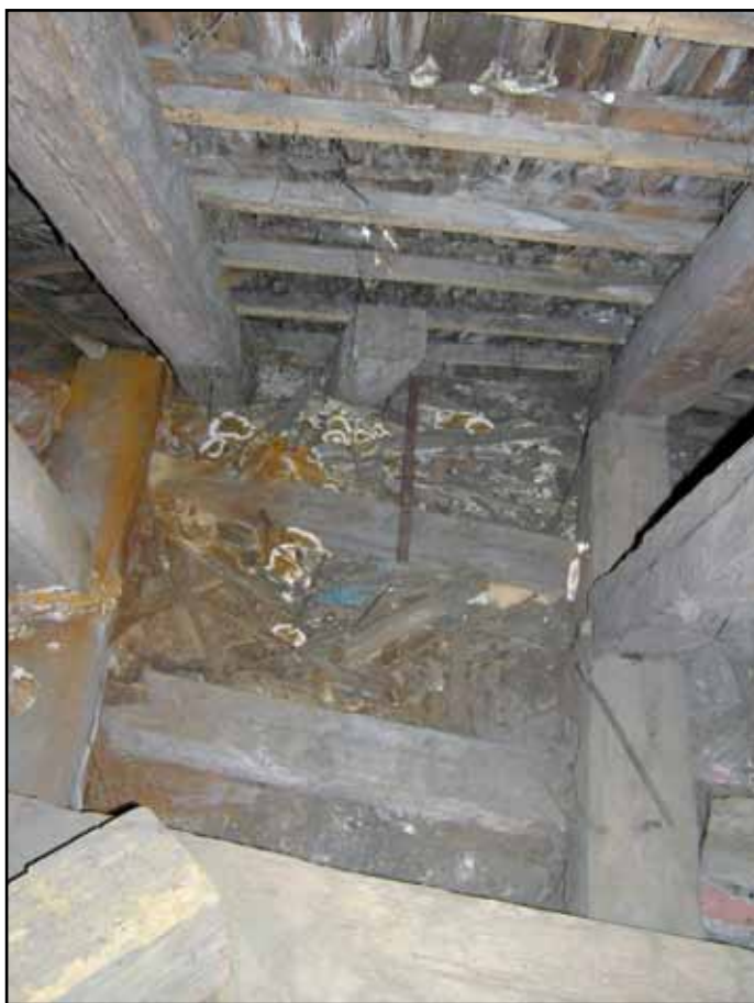
Obrázek 1. Krov sv. Barbory v Otovicích napadený dřevomorkou
