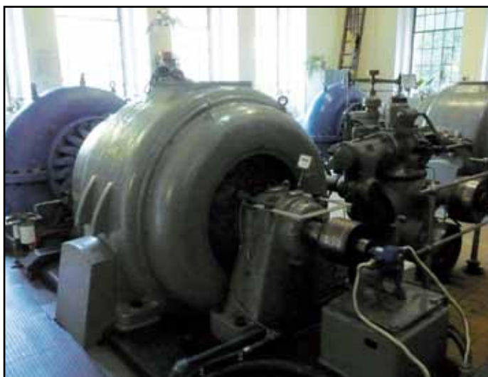
Fotografie z exkurze: Pohled do strojovny MVE Soběnov ... soustrojí turbíny a generátoru v MVE Soběnov
