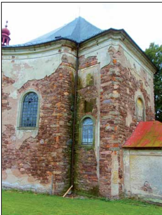
Obrázek 5. Biodeteriorace zdiva působením řas vně i uvnitř kostela Věch svatých v Heřmánkovicích
