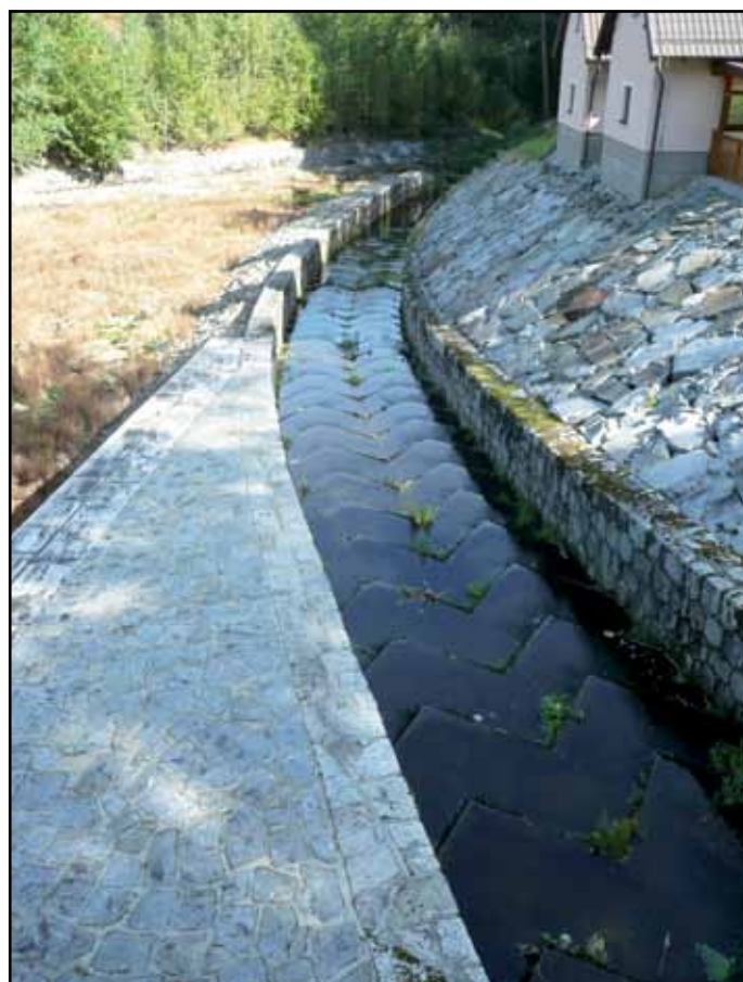
Fotografie z exkurze: Současná výpusť přehrady ... a odtokový kanál původně vorový, s úpravou dna...
