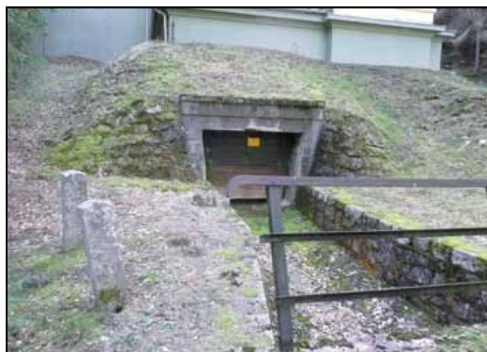
Fotografie z exkurze: Objekt na konci přiváděcího vodního tunelu ... výpustní otvor do kanálu nad elektrárnou
