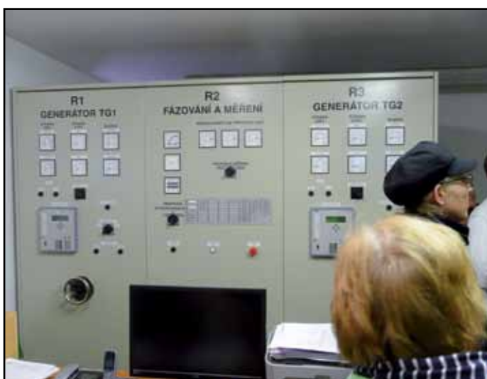
Fotografie z exkurze: Nové skříně pro ovládání soustrojí a PC, kam jsou staženy hodnoty a ovládání ...
