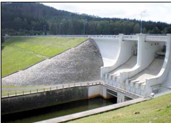
Fotografie z exkurze: Přelivová pole na přehradě Lipno I. Hráz Lipno I.
