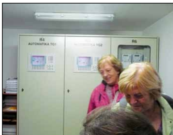
Fotografie z exkurze: Nové skříně pro ovládání soustrojí a PC, kam jsou staženy hodnoty a ovládání ...
