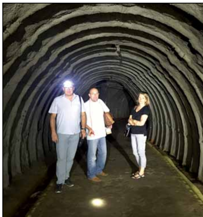
Vojířova štola (štola XXII) - interiér
