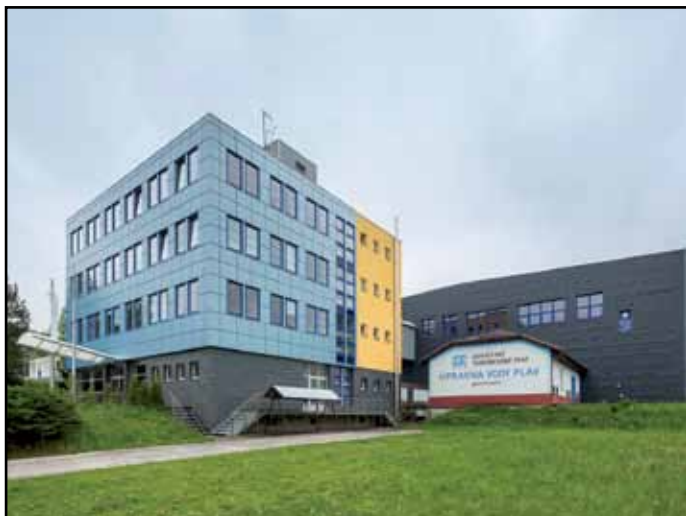
Budova úpravy vody Plav
