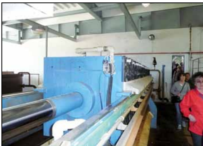
Zachycení kalů na kalolisu a jejich likvidace odvezením v kontejneru
