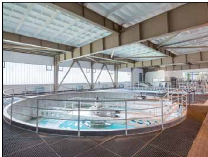
První stupeň úpravy vody - číření
