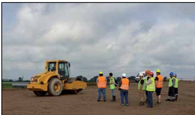
Praktické zkoušky strojníků na stavbě dálnice D35
