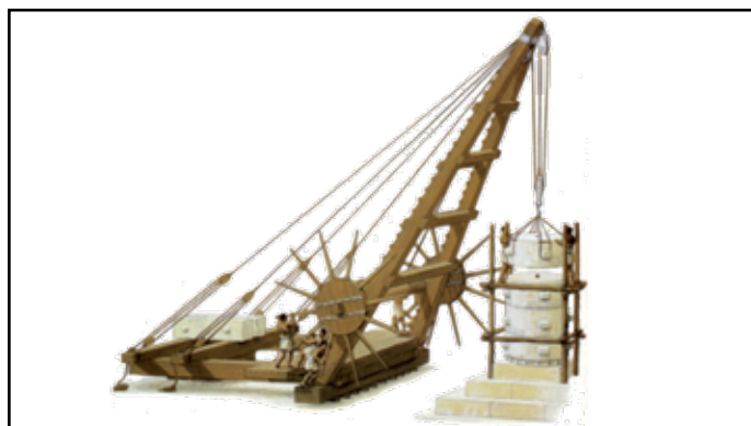
Obr. 1 Řecký jeřáb zachycený při stavbě dórského sloupu
