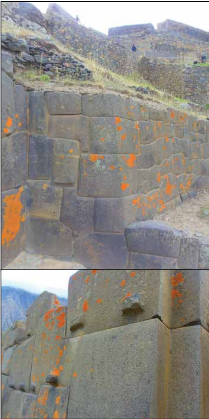
Obr. 12 Ollantaytambo, nahoře hraniční pevnost vybudovaná Pachacútecem Yupanquim, dole zdívo s úchyty, které stavitelé nestačili zahladit; nabízí se důvod náhlého odchodu
