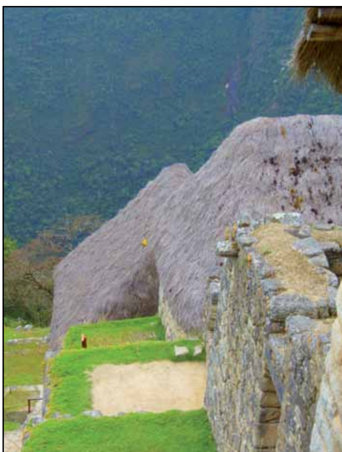
Obr. 25 Machu Picchu, detail konstrukce zdi a pohled na střešní krytinu
