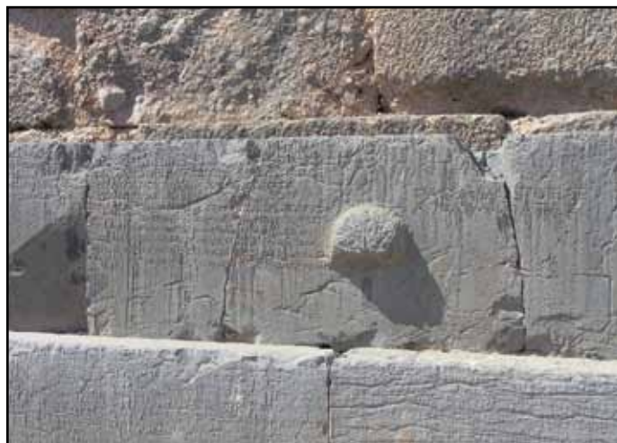
Obr. 11 Blok vápence s ještě neodstraněným manipulačním úchytem
