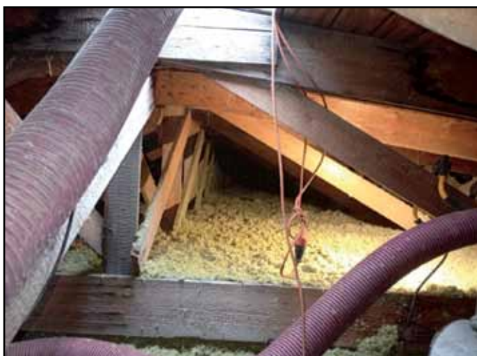
Zateplení střešní konstrukce, DT U Výstaviště
